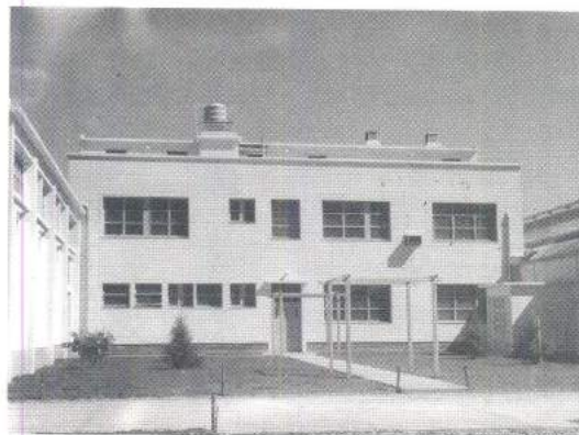
Figura 19.- Parte central del nuevo edificio de Metalurgia, inaugurado en julio de 1960.
