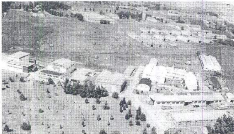
Figura 31.- Vista del edificio de Metalurgia en 1962.
