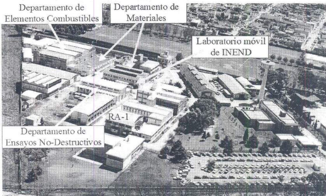
Figura 33.- El CAC con la Gerencia de Tecnología que dejó Sabato en 1973. A la izquierda termina el CAC y comienza el INTI. Parte de estos terrenos fueron cedidos posteriormente a CNEA para construir los edificios que conforman el Tandar.
