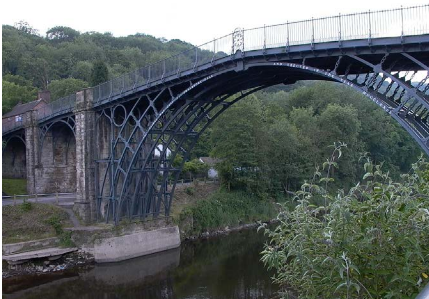
Primer puente de hierro fundido. Fue construido sobre el río Severn, en Coalbrookdale, Inglaterra, en 1779.
